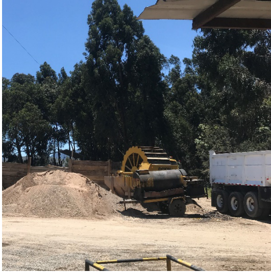
Fotografía 3. Patio de acopio de agregados pétreos.
