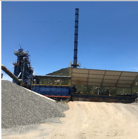
Fotografía 5. Planta de mezcla asfáltica
