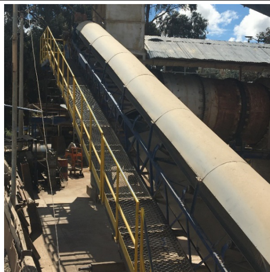
Fotografía 6. Banda transportadora de materia pétreo.
